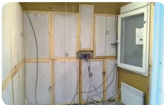
25. ábra: A hőtároló vakolatpanelek előállítás és beépítése a modellházba
