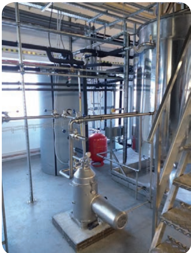
33. ábra: Sűrű mikrokapszula szuszpenzió előállítására szolgáló szeperator centrifuga
