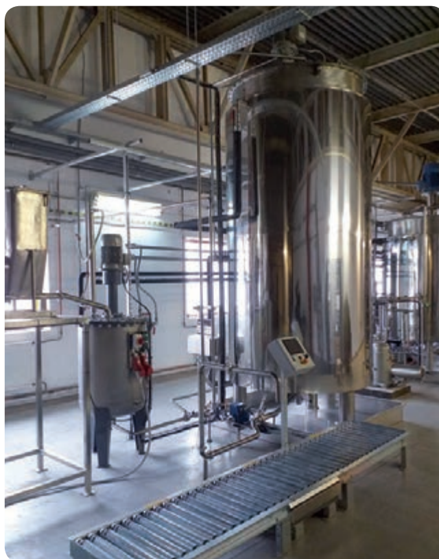
34. ábra: Sűrű szuszpenzió fogadó és kiserelő tartály (felső kép) és a gélesítő oldat előkészítő rendszer (alsó kép)
